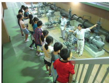
各家庭にある水道メーターや配水塔にくみ上げるポンプの説明を聞いています。（配水場）
