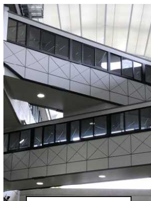
南北をつなぐ通路
