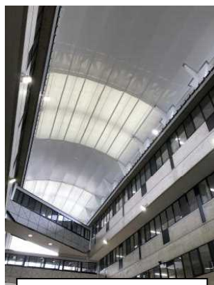
アトリウムから見た屋根
