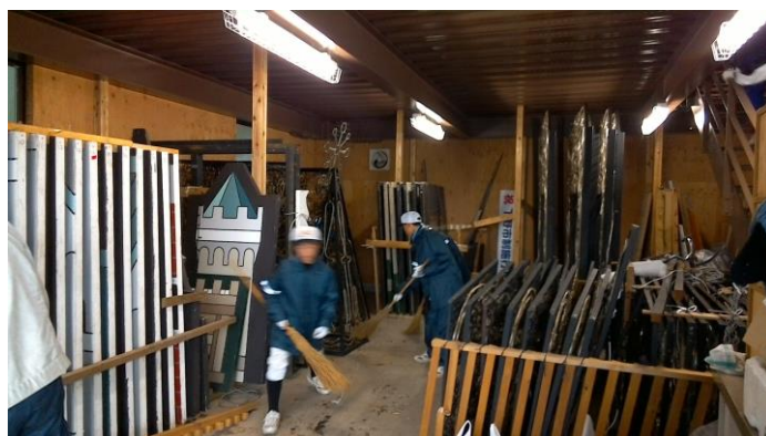
取り出した後の作業場の清掃
