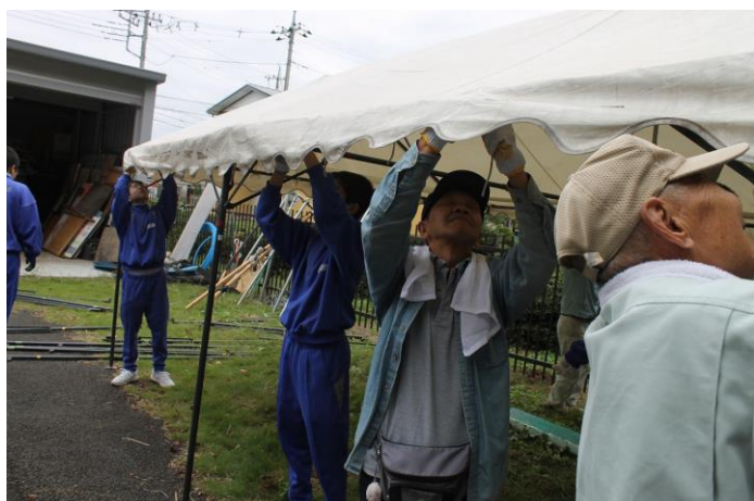
休憩所となるテントの組立て
